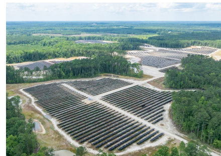
89 MW, TITAN Pile Waverly, VA
