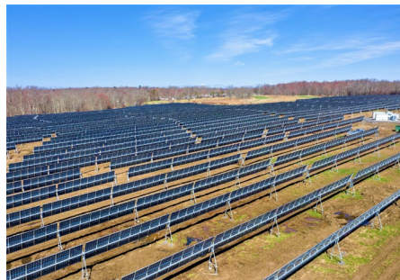
4.7 MW, A-Frame Pulaski, NY
